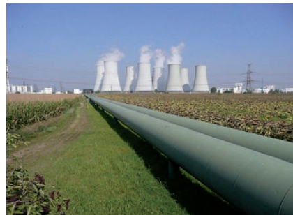
Obr. 4 JEBO V2 – teplovod mieriaci do elektrárne
