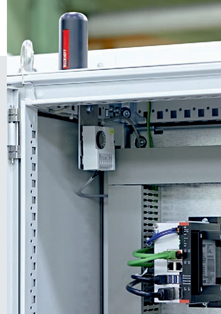
S ultrakompaktným priemyselným počítačom C6030 (dole) a kupolou CU8210-M001 kompatibilnou s IP66 (hore) používa spoločnosť Texpa najmodernejšie komponenty riadenia na báze PC.
