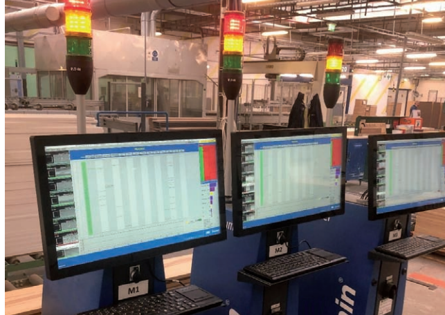
Systém automatickej kontroly bude strážiť kvalitu povrchovej úpravy dielcov v záverečnej časti linky.
